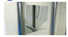
ビバミラーフィルム + アクリル板 t2.0+ ア ルミ複合板 t3.0 をカット加工
